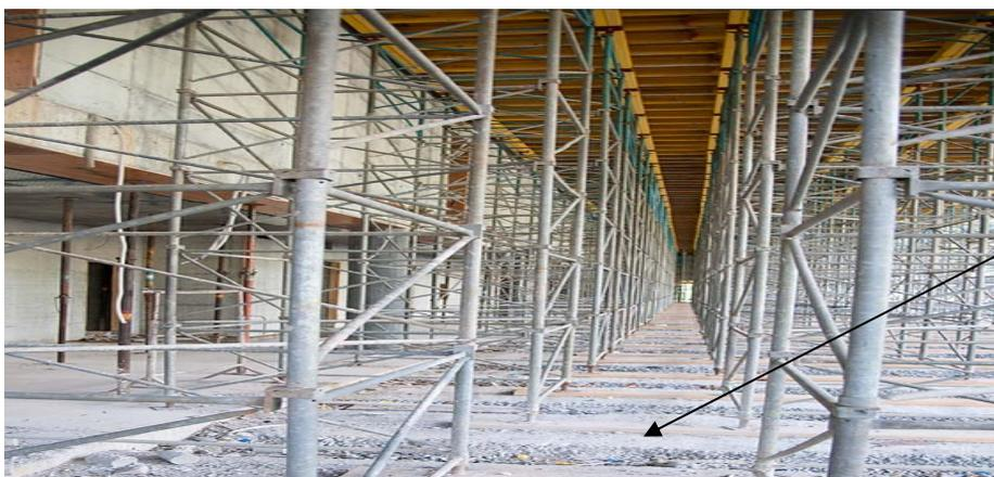
Semelles en béton pour appui des tours PAL.
